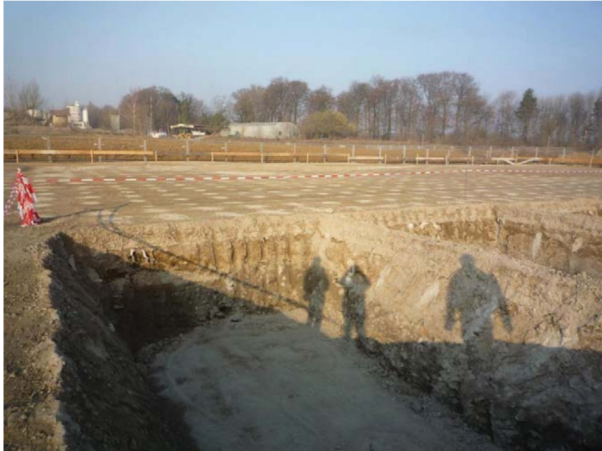
Bild 7 Ausführungsbeispiel - Baufeld nach Herstellung der Stabilisierungssäulen im Raster von 1,20 m x 1,20 m unter der Bodenplatte (abgewalzt)
