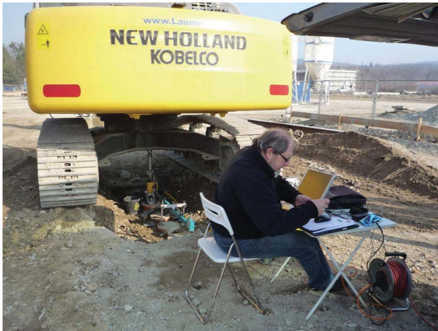
Bild 8 Versuchsaufbau mit Standardwiderlager für den in Bild 9 dargestellten Belastungsversuch (Kettenabstand zur Probesäule \approx 1,2 m)
