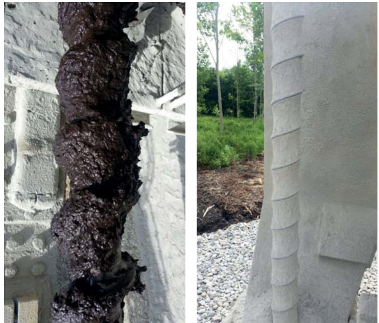
Bild 3 und 4: Geräteeinstellung beim Probefeld (Überprüfung des anstehenden Baugrunds und der sauberen Materialförderung ohne Bodeneinmischung)
